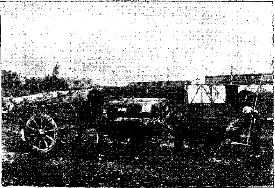
Fig. 19.—Transporte de la cañería en carreta.
